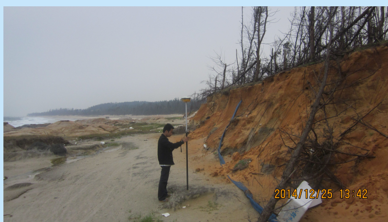
2014 年海南文昌铺前镇海南角附近侵蚀岸段
