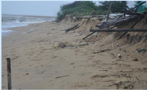
东方市新龙镇岸线侵蚀状况 (拍摄于 2018 年 9 月 28 日)
