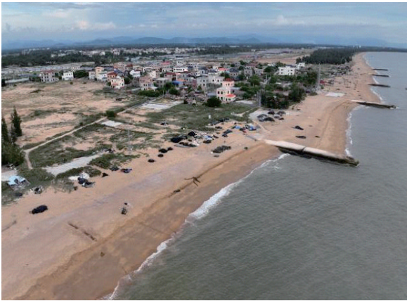
东方市新龙镇新村岸段侵蚀状况
